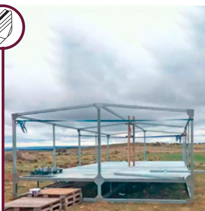
Montaje de estructura
